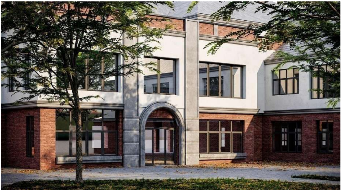
Рис.4. Фрагмент головного фасаду
