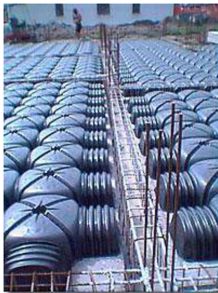
Рис.1. Пластмасові елементи вентиляваного перекриття
