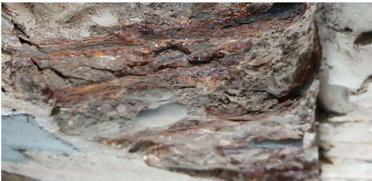
Рис.2. Консольна частини збірної плити ПС-4-5н-16 в осях Б-В. Карбонізація на усю висоту розкриття . Корозія арматури до 70%.
