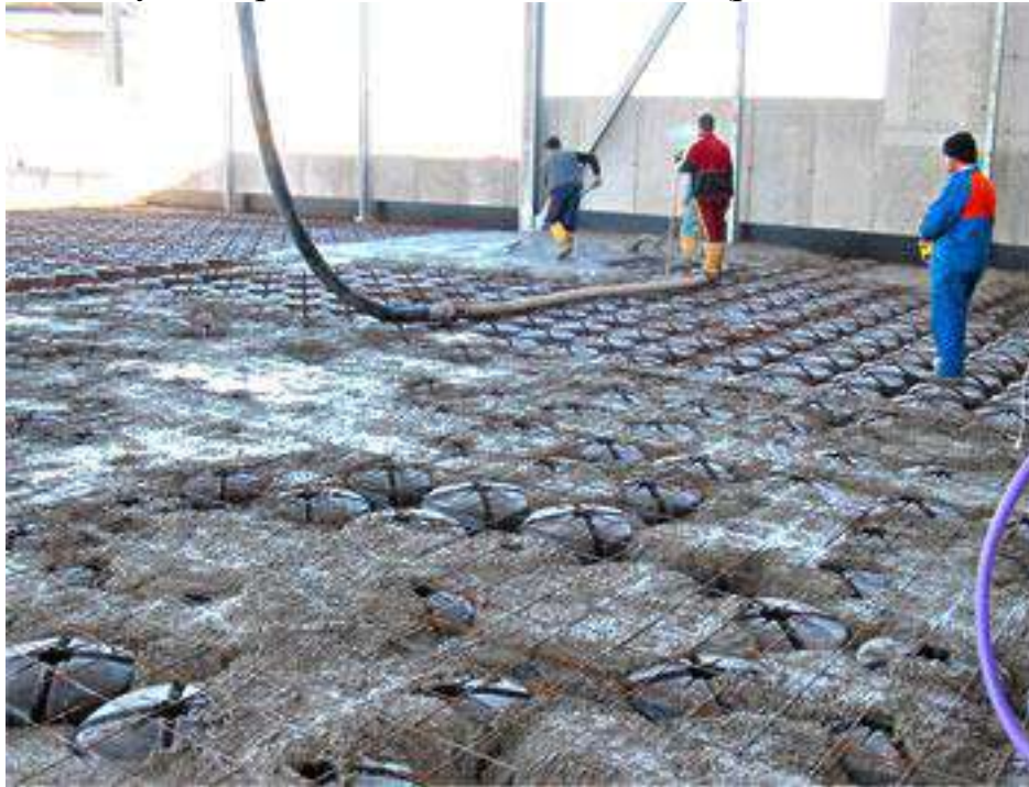
Рис. 4. Бетонування вентилязованого перекриття за допомогою бетононасоса
