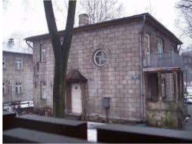
Рис. 1. Будинок 1939 р. побудови з автоклавного газобетону на цементному в'язучому без зовнішньої обробки, м. Рига, вул. Ельвірас, буд.15
