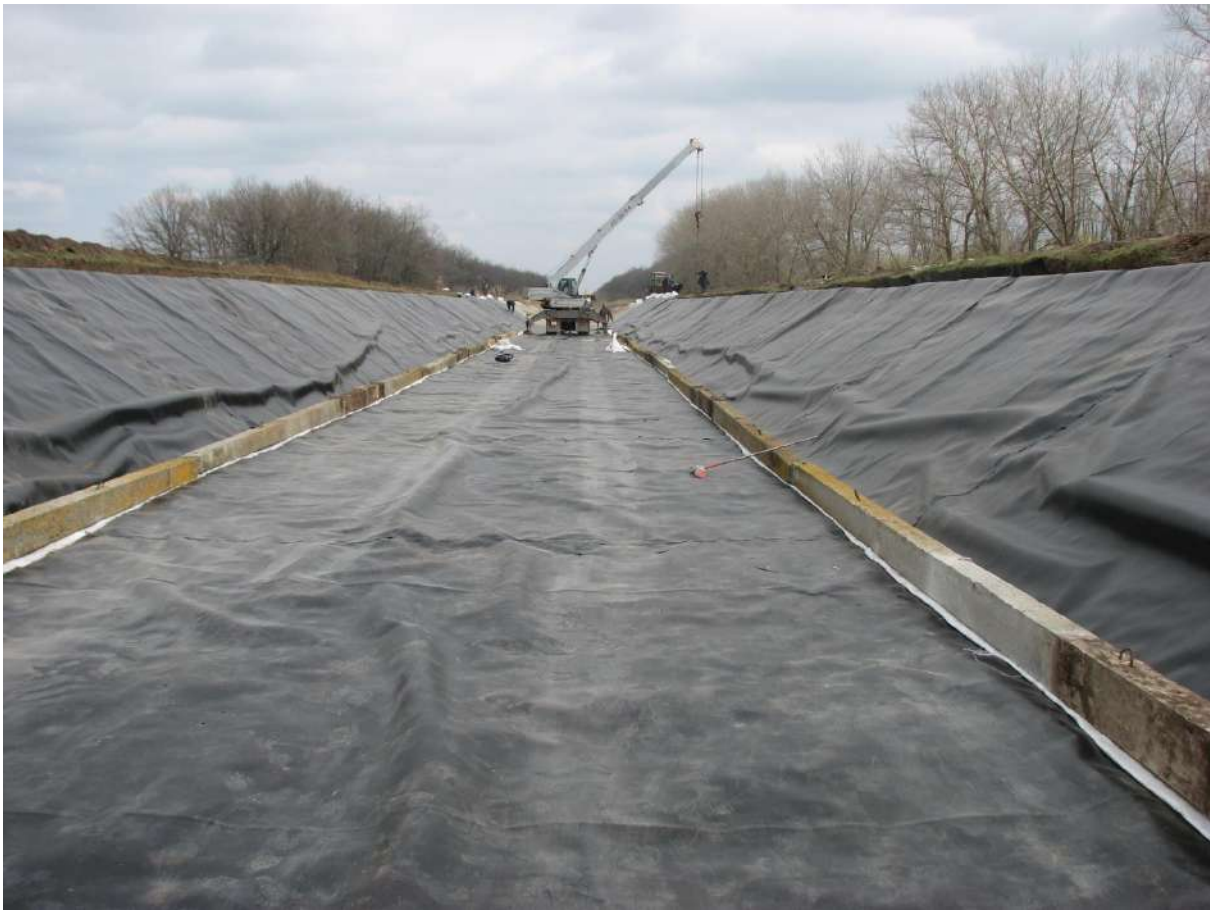
Рис. 4– Технічний стан Інгuleцького магістрального каналу (укладання геомембрани) після ремонтних робіт( 2013 рік)
