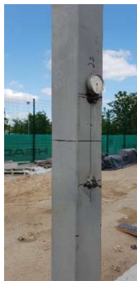
Рис. 3. Вимірювання деформацій стояка індикаторами з точністю вимірювання 0,001 мм
