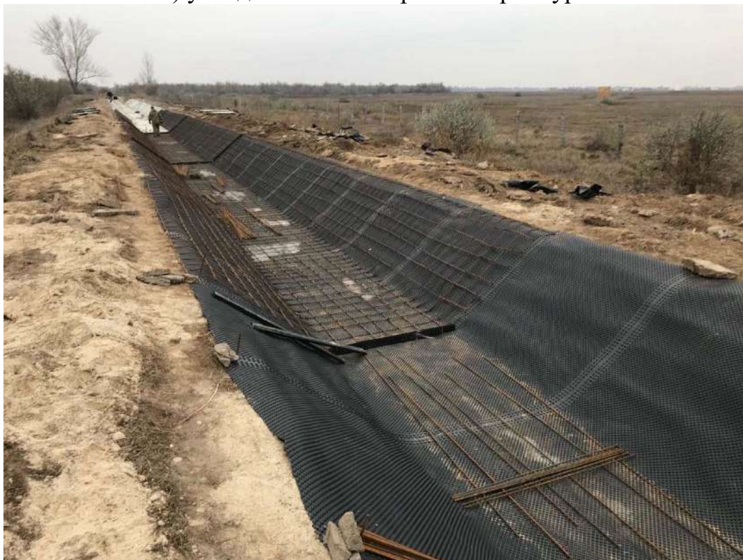
б) проведення бетонних робіт
