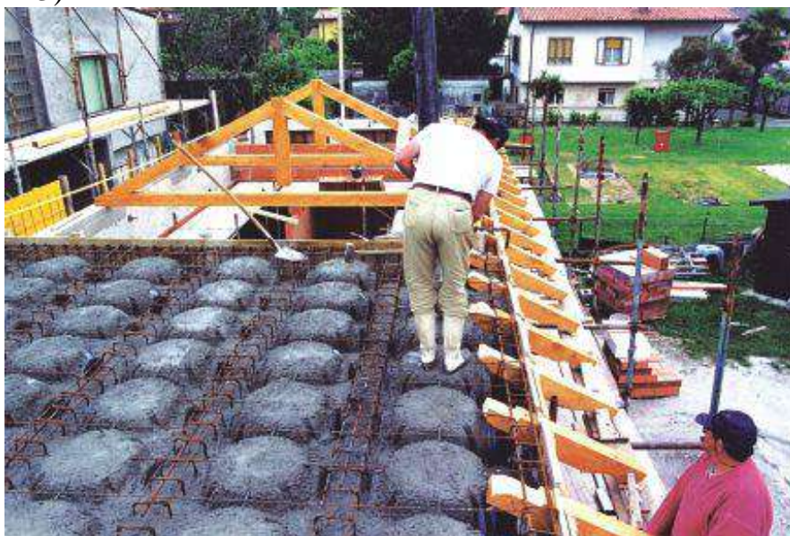
Рис. 3. Пристрій вентиляційного перекриття над останнім поверхом
