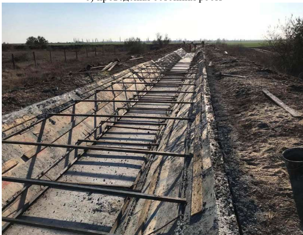
Рис. 5- Капітальний ремонт каналу Р-4-2 (2018 р.)
