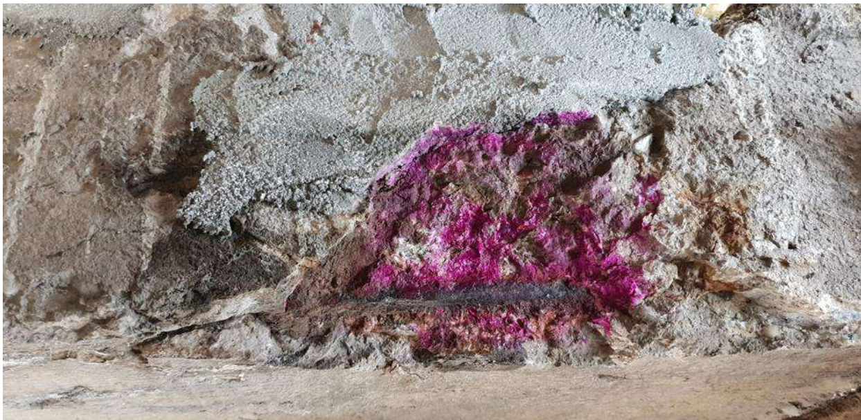
Рис. 1. Балка за віссю 26 монолітної плити ПМ-26-27 в прольоті в осях Б-В. Карбонізація до 10мм. Корозія арматурної сталі.
