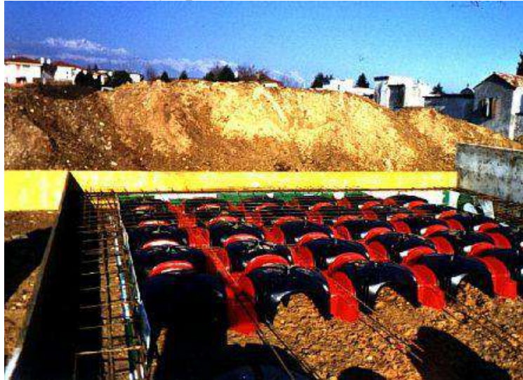
Рис.2. Опорна вентиляційний перекриття підлоги цокольного поверху
