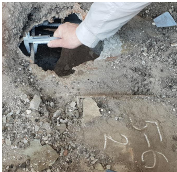
Рис. 3. Вхідний отвір у плитній частині прогонових будов моста
