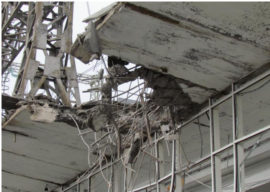
Рис.1. Наслідки ракетного удару, руйнування, пролам консольної частини плити несучого покриття будівлі
