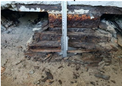
Рис. 4. Корозія опорної частини. Продукти пластинчастої корозії сталі до 7 мм
