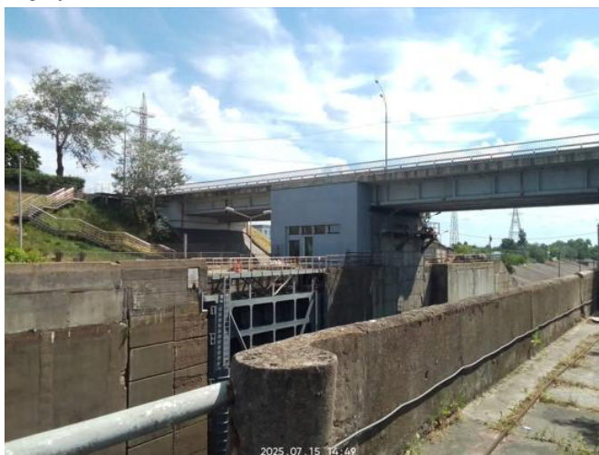
Рис. 1. Загальний вигляд моста через шлюз зі сторони верхнього б'єфу
