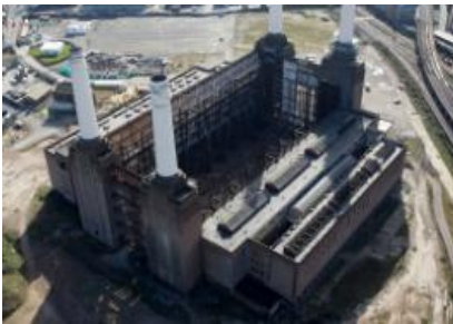
Рис. 1. Електростанція Батерсі до відновлення
