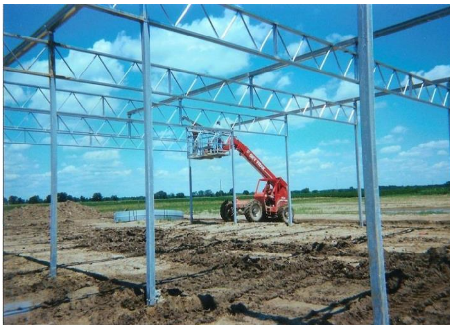
Рис. 2 - Монтаж елементів покриття
