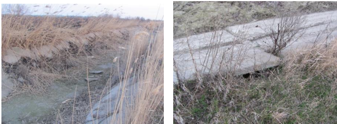
Рис. 1.4 – Стан облицювання каналу Р-1 ПК132- ПК132+300
