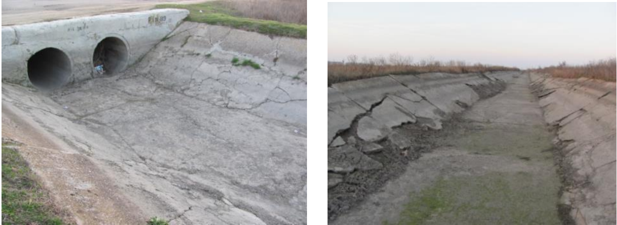
Рис. 1.2 – Стан облицювання каналу Р-1 ПК40-ПК41
