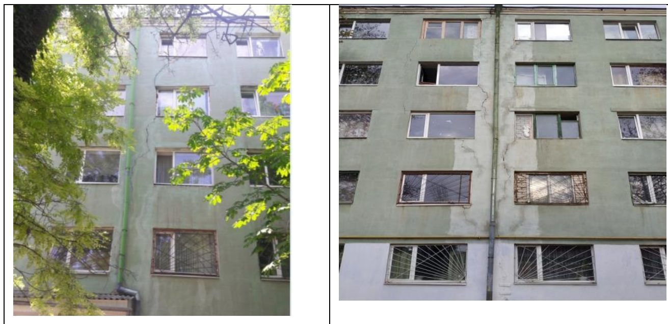
Рисунок 2 – Тріщина на фасадах будівлі: – а) на головному, 13.02.2018р. – б) на дворовому, 27.11.2018р.
