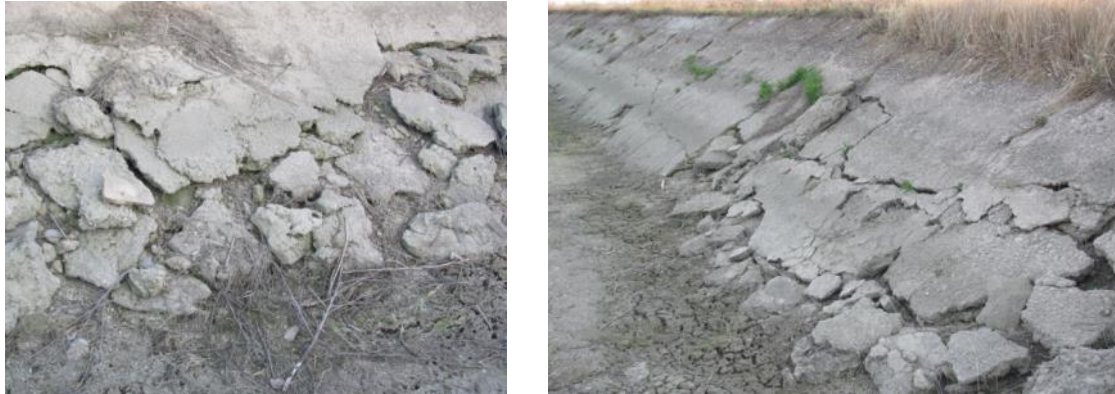
Рис. 1.2 – Стан облицювання каналу Р-1 ПК40-ПК41
