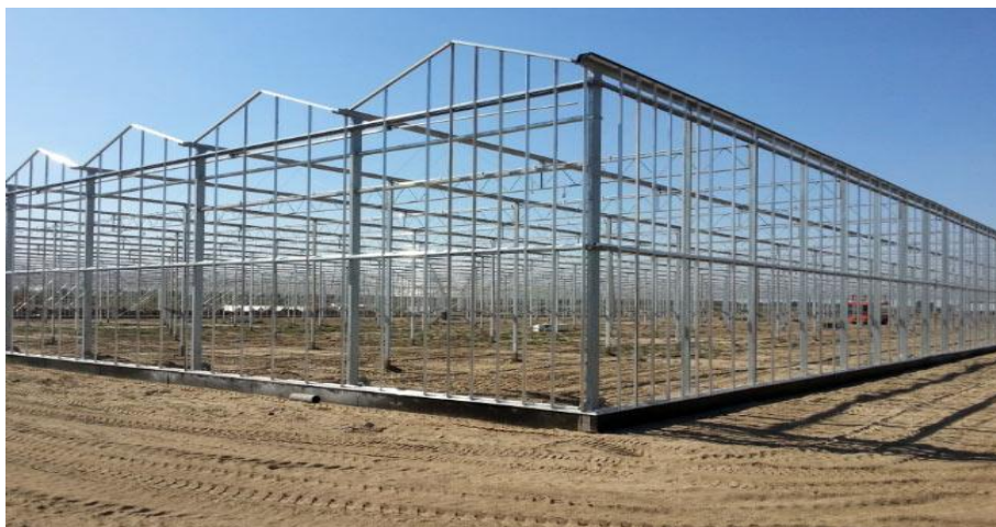
Рис. 1 - Металевий каркас теплиці
