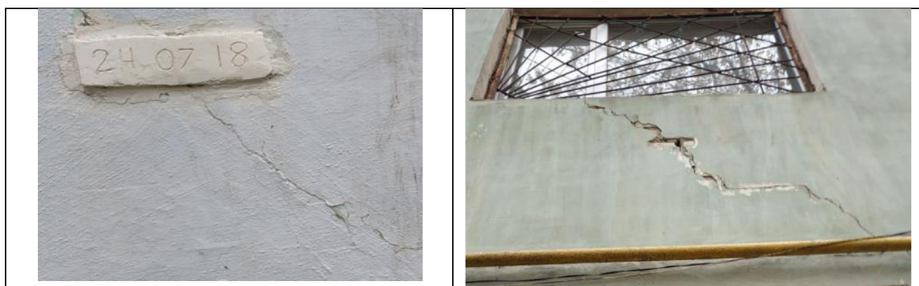
Рисунок 3 – Фіксація розвитку тріщин гіпсовими маяками
