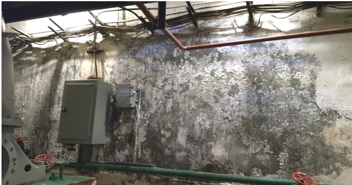
Рисунок 1 - Фільтрація води в докових частинах насосних станцій
