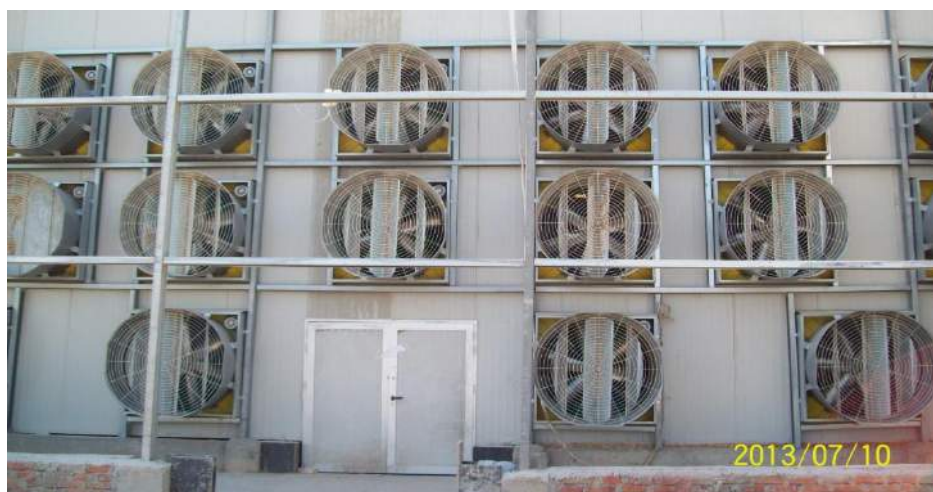
Рисунок 3. Тунельна вентиляція в пташнику
