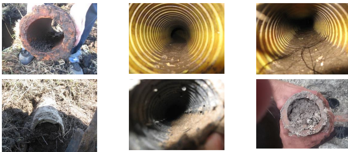
Рисунок 2. Стан замулення дрен та колекторів на сільськогосподарських територіях [2, 3]
