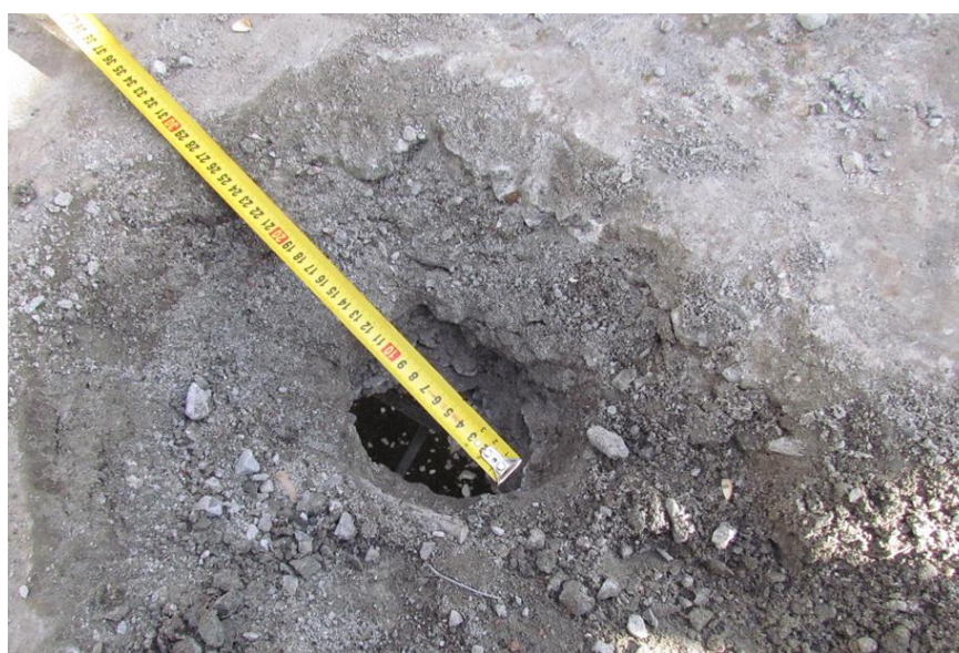
Рис. 3. Вхідний отвір у плитній частині залізобетонних балок прогонових будов моста
