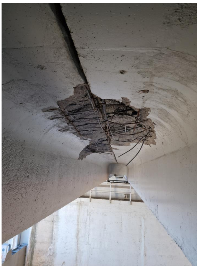
Рис. 5. Вивал бетону в плитній частині залізобетонних балок прогонових будов
